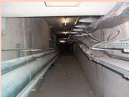
Galerie de câble
